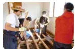
家の床下の泥をかき出す様子
