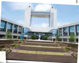
名古屋国際会議場の正面入口
