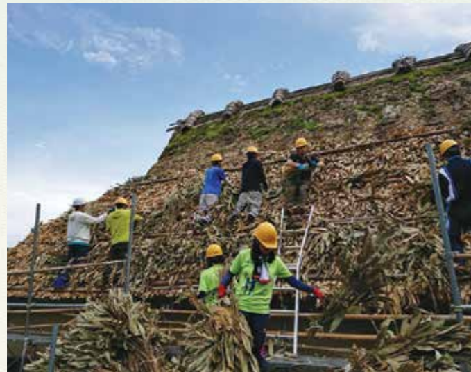
日本でも数棟しか残っていない笹葺き家屋の維持管理・修復活動をおこなっている。屋根には刈り取った笹が使用されている。
