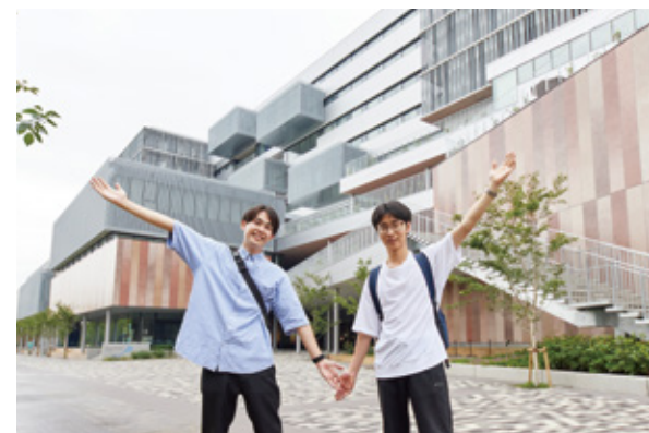
新棟（H棟）は地上9階建てで延べ床面積は約4万7000平方メートルと、立命館大学で2番目に大きな施設となっています。
